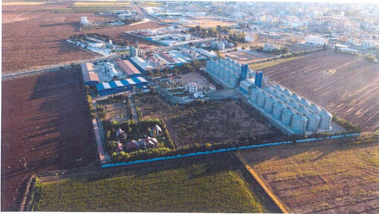
Platinyum Tarım Depolama Tesisleri
