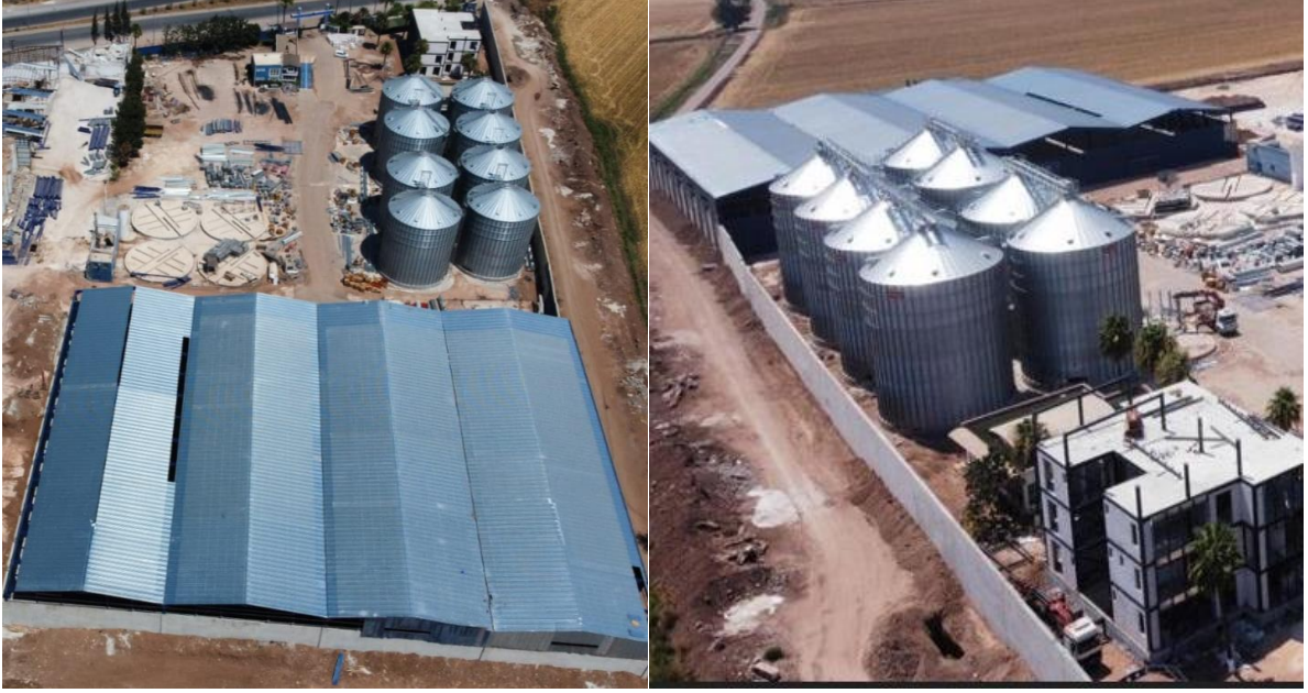
İnşaatın Rapor Tarihindeki Hali
